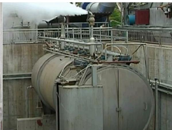
图12 自压热闷罐（实现钢渣快速消解、稳定化处理）
