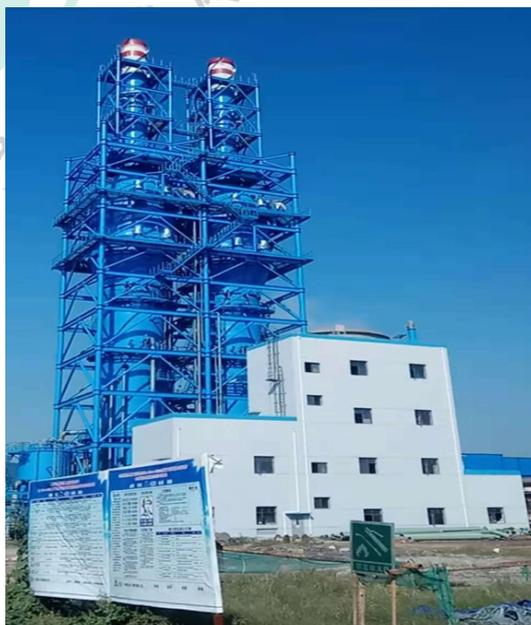
图 2 75、100 吨燃煤锅炉脱白改造后排烟四季无白
