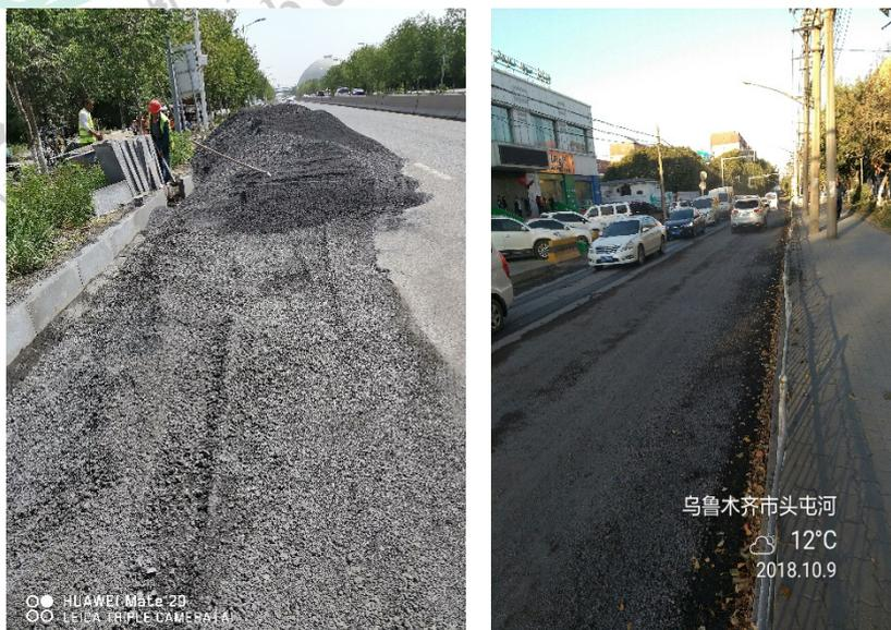
图 2 城市道路钢渣回填替代基层和水稳层的施工现场
